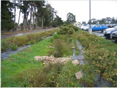
dlo rigol: 'bioswale'
